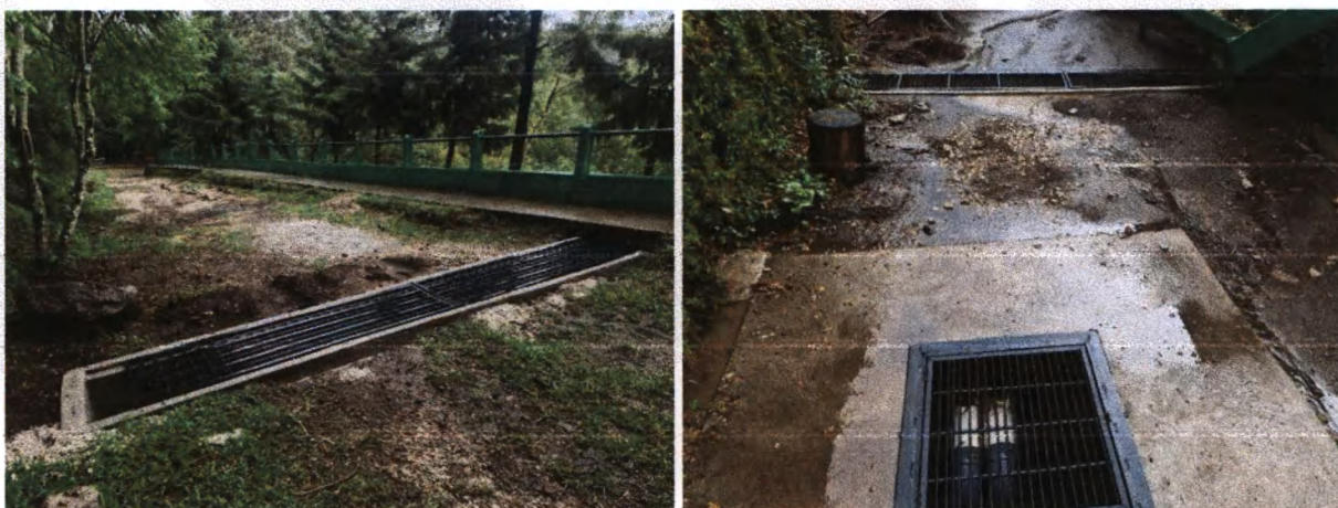
Foto 21-22: Zanja y pozo de absorción para conservación de suelo y manejo de agua pluvial en el mirador principal y granja educativa
